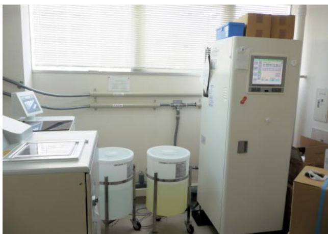
透析室内機械室
